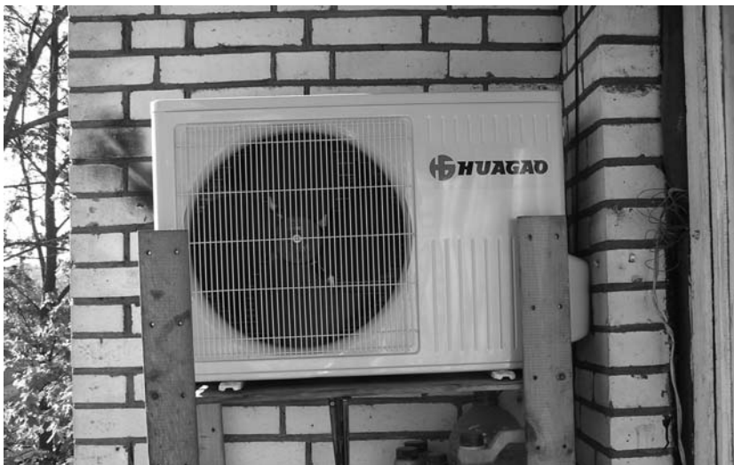
Рис. 3.3. Способ установки выносного блока непосредственно на лоджии
