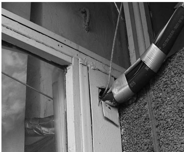
Рис. 3.10. Прокладывание соединительных межблочных коммуникаций в любое подходящее отверстие
